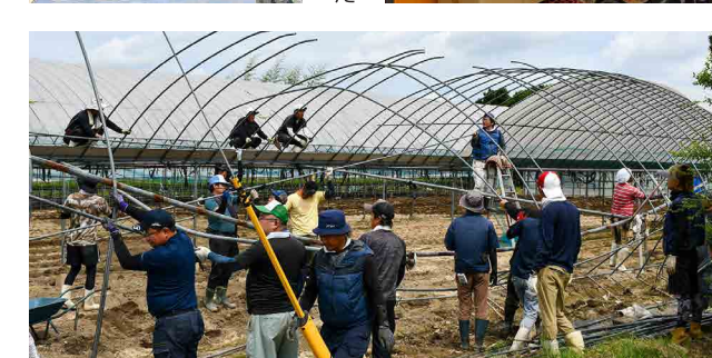
被災ハウスの復旧作業を行うJ A いちご部会広川支部
